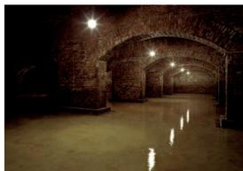
1877-80 entstand nach Plänen des Ingenieurs Otto Lueger auf der höchsten Stelle der Mathildenhöhe der Hochbehälter des städtischen Wasserwerks. Das Wasserreservoir besteht aus zwei gemauerten Kammern mit je sechs Tonnengewölben. Auf der Aussichtsplattform des Wasserreservoirs erbaute Joseph Maria Olbrich im Rahmen der dritten Ausstellung der Künstlerkolonie 1908, der „Hessischen
